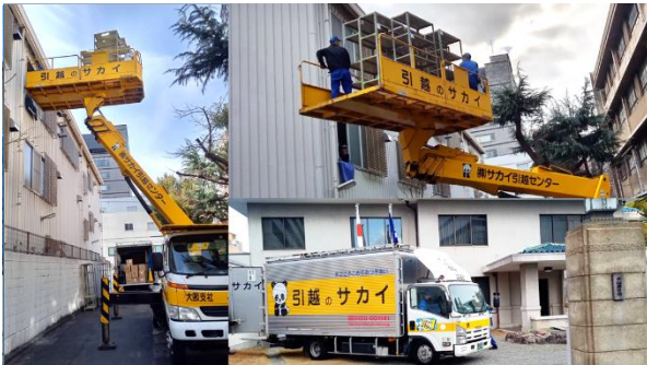
大阪府庁移転作業
