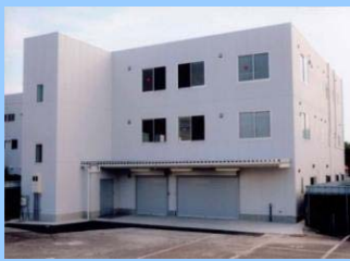
(株)エレコン 電気工事 平成22年7月
