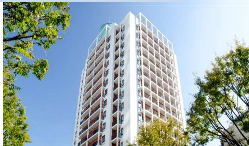
大型マンション一斉入居
